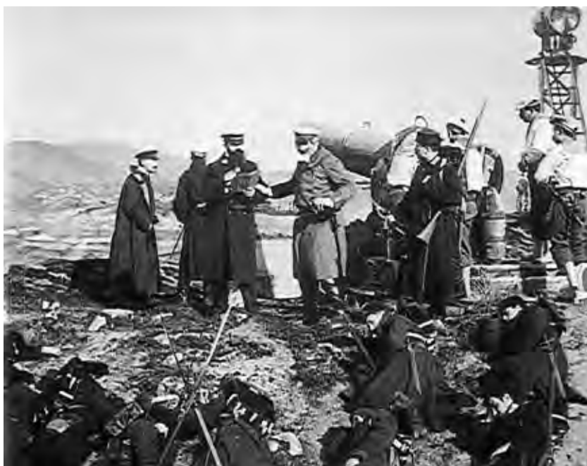
Ryc. 51. Kadr z filmu Wojna rosyjsko-japońska, nr 4 ( Guerre russo-japonaise N°4 ). Za aktorami znajduje się malowane tło, działo zostało wykonane z tektury, a za szperacz wojskowy posłużyła lampa stosowana przy realizacji filmów.
